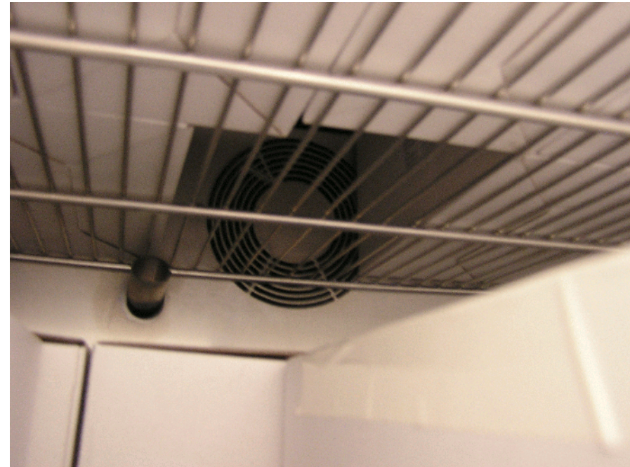
Bild 2: überladene Kammer - Lüfter zugestellt
